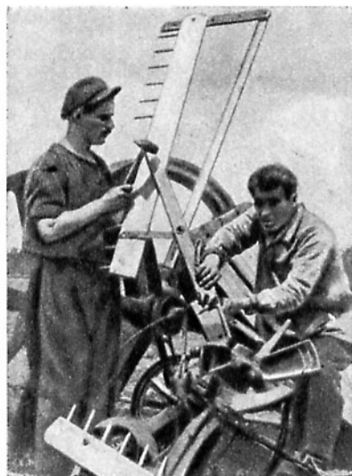
РЕМОНТ ЖАТКИ В МТС
